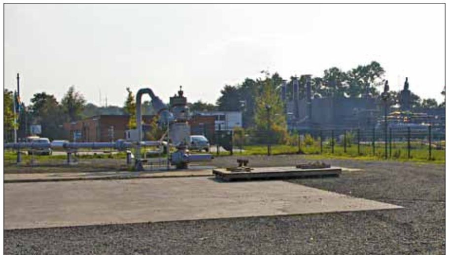
Kopf einer Gaskaverne beim Betriebsgelände der NUON und der Essent.
