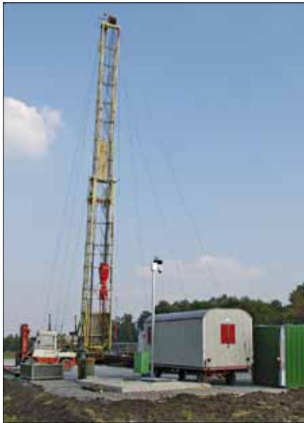
Aufwältigungswinde auf dem Bohrplatz 4.
