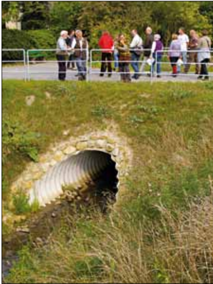
Vergrößerter Straßendurchlass mit Steinsediment. Foto: Werner Gessner-Krone
