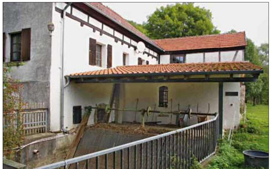
Die ehemalige Säge- und Papiermühle von Schloss Erpernburg ist seit 1990 ein Wasserkraftwerk. (Fotos: Werner Gessner-Krone)
