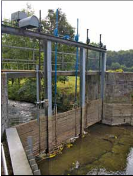
Almwehr zum Ableiten des Wassers in den Mühlenobergraben.
