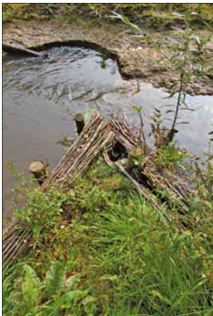
Faschinenverbau und natürliche Auskolkung. Foto: Werner Gessner-Krone
